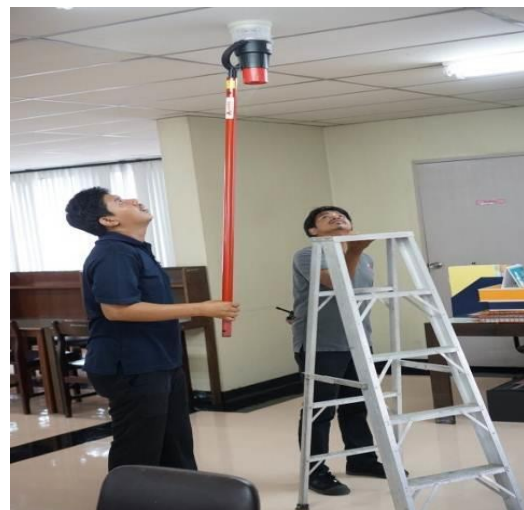
รูปที่ 27 เจ้าหน้าที่ตรวจสอบสัญญาณเตือนภัย และอุปกรณ์ตรวจจับควัน
