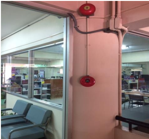
รูปที่ 26 ถึงดับเพลิง สัญญาณเตือนภัย และอุปกรณ์ตรวจจับควัน
