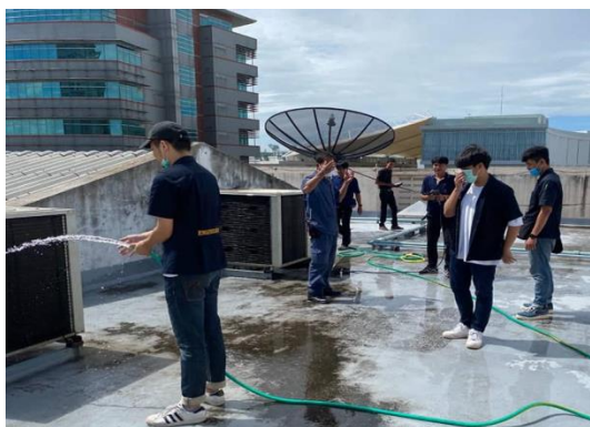
รูปที่ 2 การทำความสะอาดเครื่องปรับอากาศโดยแผนกซ่อมบำรุง มหาวิทยาลัยรังสิต
