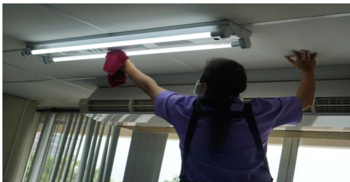
รูปที่ 5 การทำความสะอาดหลอดไฟ
